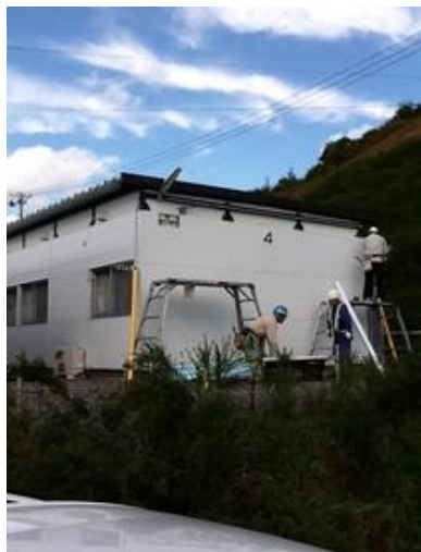
・仮設住宅では、寒さ対策の二重サッシの工事が各戸で行われています。【写真・左】
